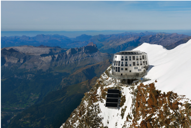
Refuge du Goûter 2, 3825m d'altitude, Saint-Gervais-les-Bains, France © Charpente Concept
