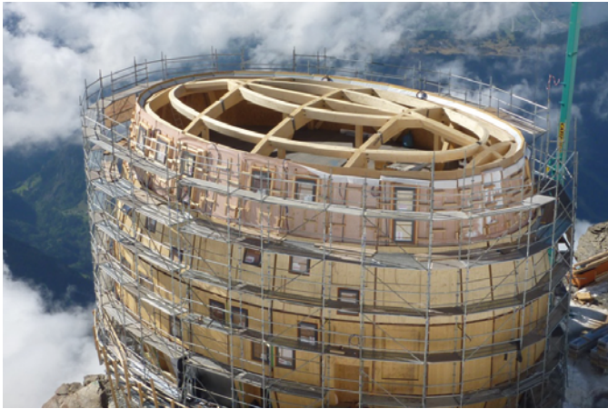
Refuge du Goûter, 3825 m d'altitude, Saint-Gervais-les-Bains, France © Charpente Concept
