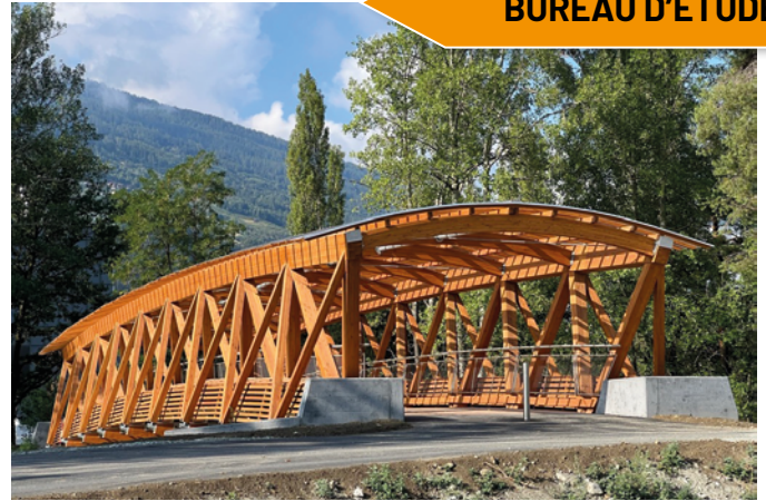
Passerelle couverte de Sion – État du Valais - © Charpente Concept
