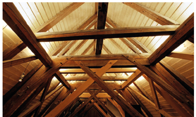
Restauration du Château de Nyon – Canton de Vaud - © Charpente Concept
