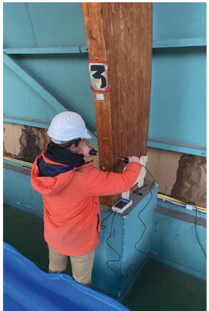
Complexe sportif de la Licorne, Dunkerque © CBS-CBT
